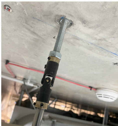
Exemple de fixation par cheville scellée dans le plafond
